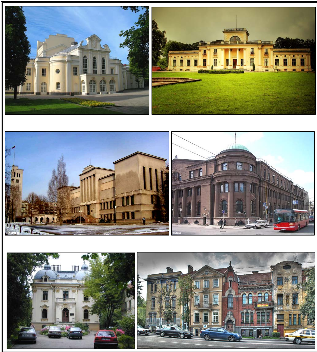
3.13 pav. Kaune, Trakų Vokėje ir Vilniuje tarpukariu pastatyti istorizmo ir modernio (secesijos) architektūros objektai.
